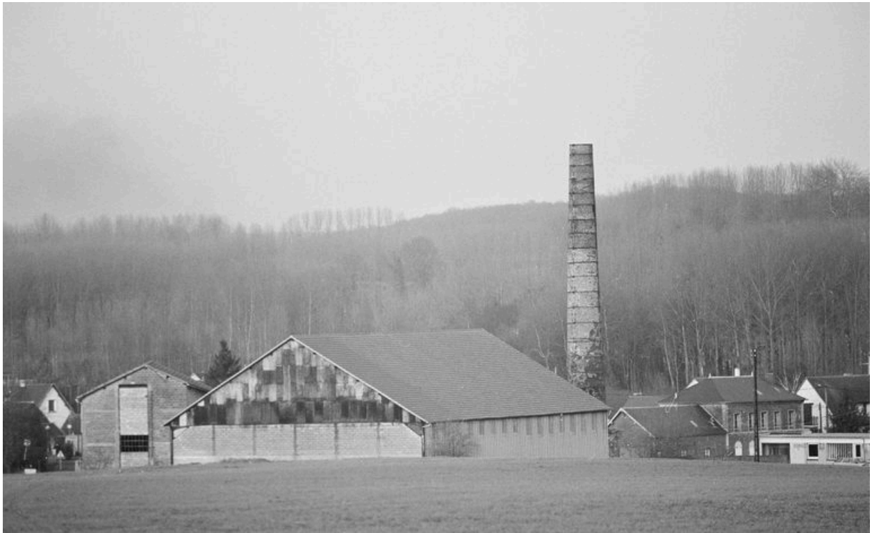
Bâtiments de l'usine et cheminée en brique.
