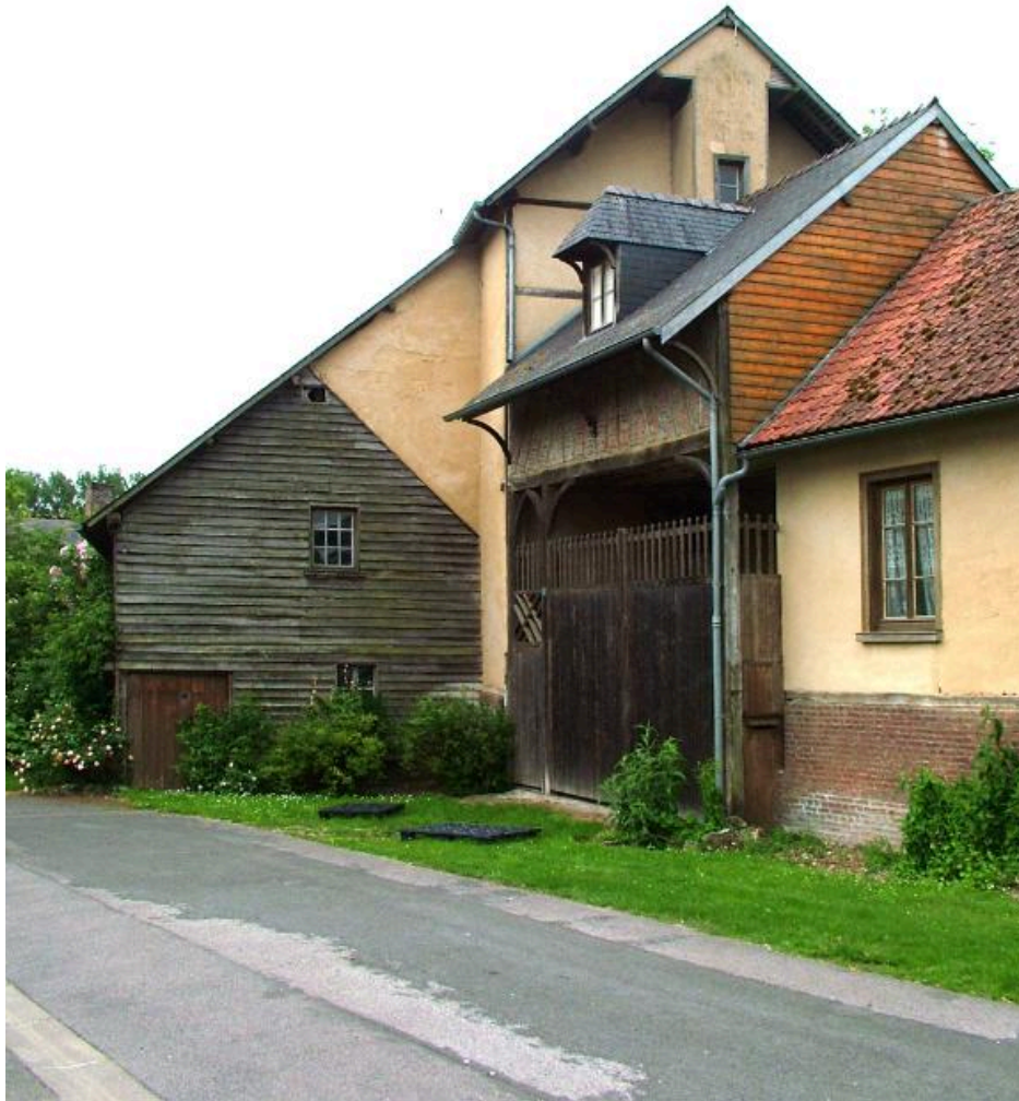
Vue depuis la rue du Moulin.
