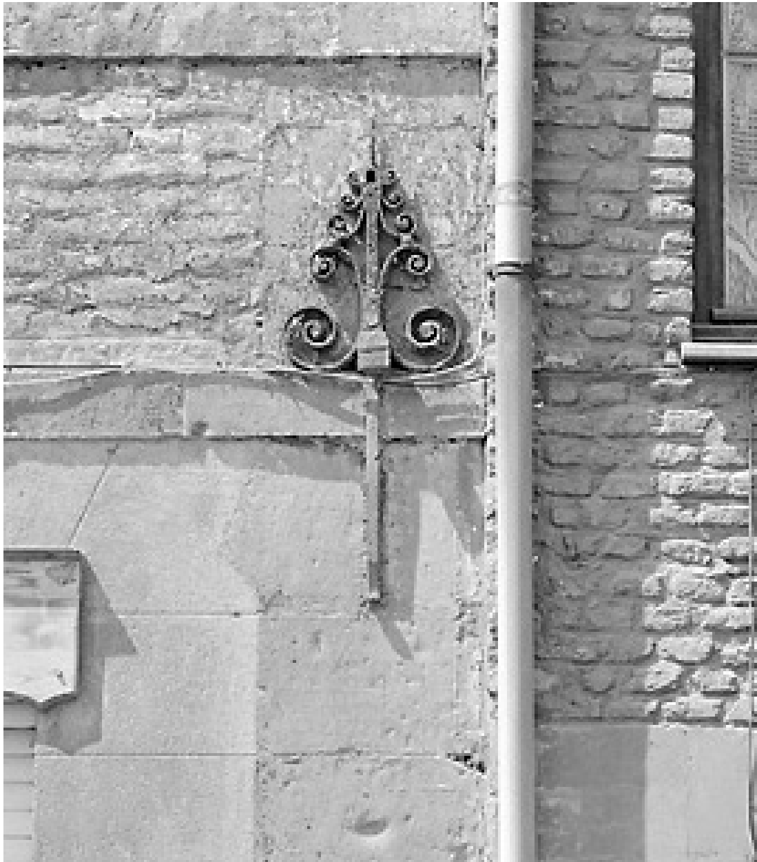
Maison n° 59, détail : fer d'ancrage.
