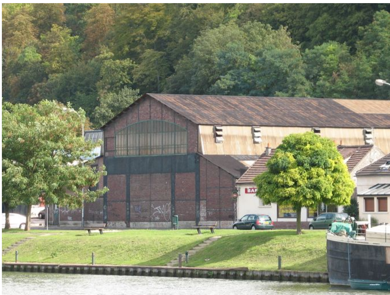
Vue générale de l'usine.
