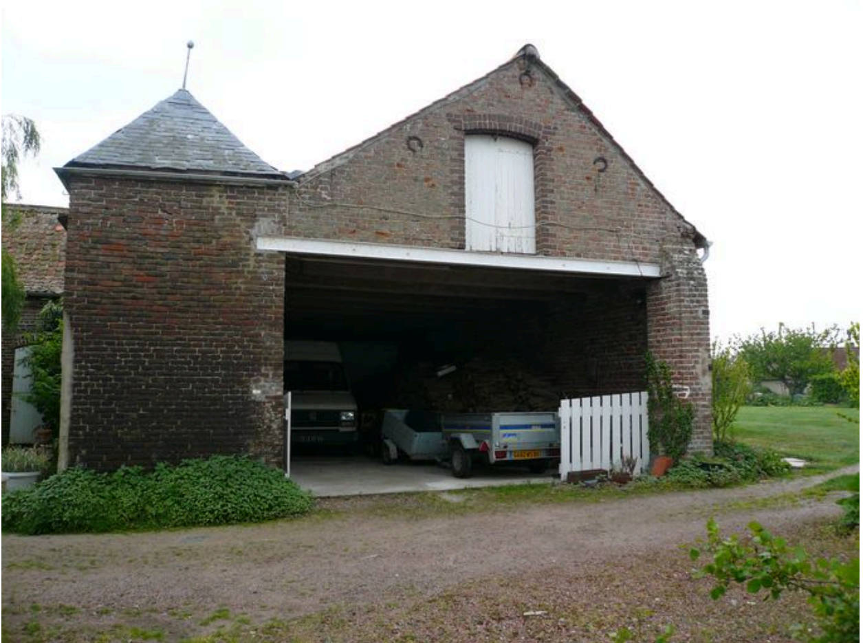
Vue sur la charretterie augmentée du grenier, située à l'entrée de la partie ferme.
