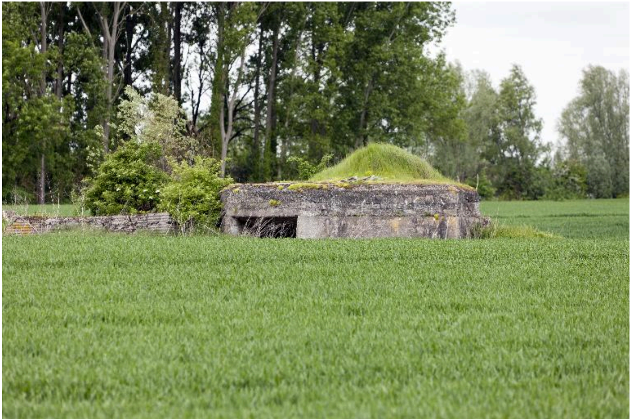
Vue générale vers le nord-ouest
