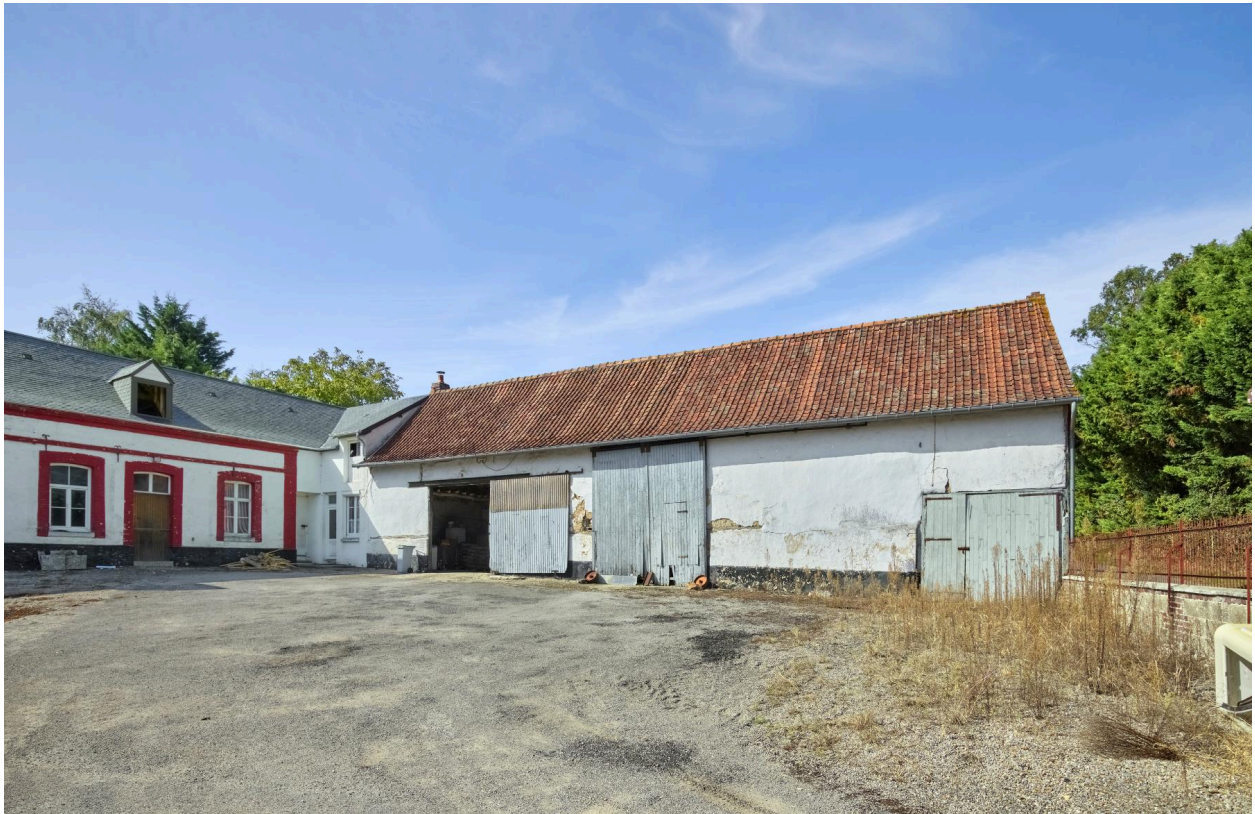
Ferme Boinet (3, rue de Vercourt). Façade sur cour de la grange.
