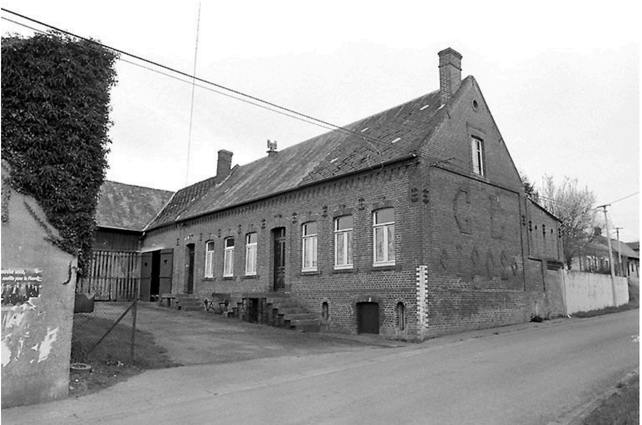
Vue du logis depuis le nord-est.
