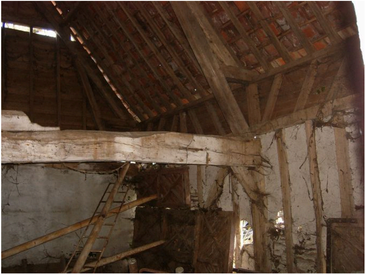
Vue intérieure de la grange.
