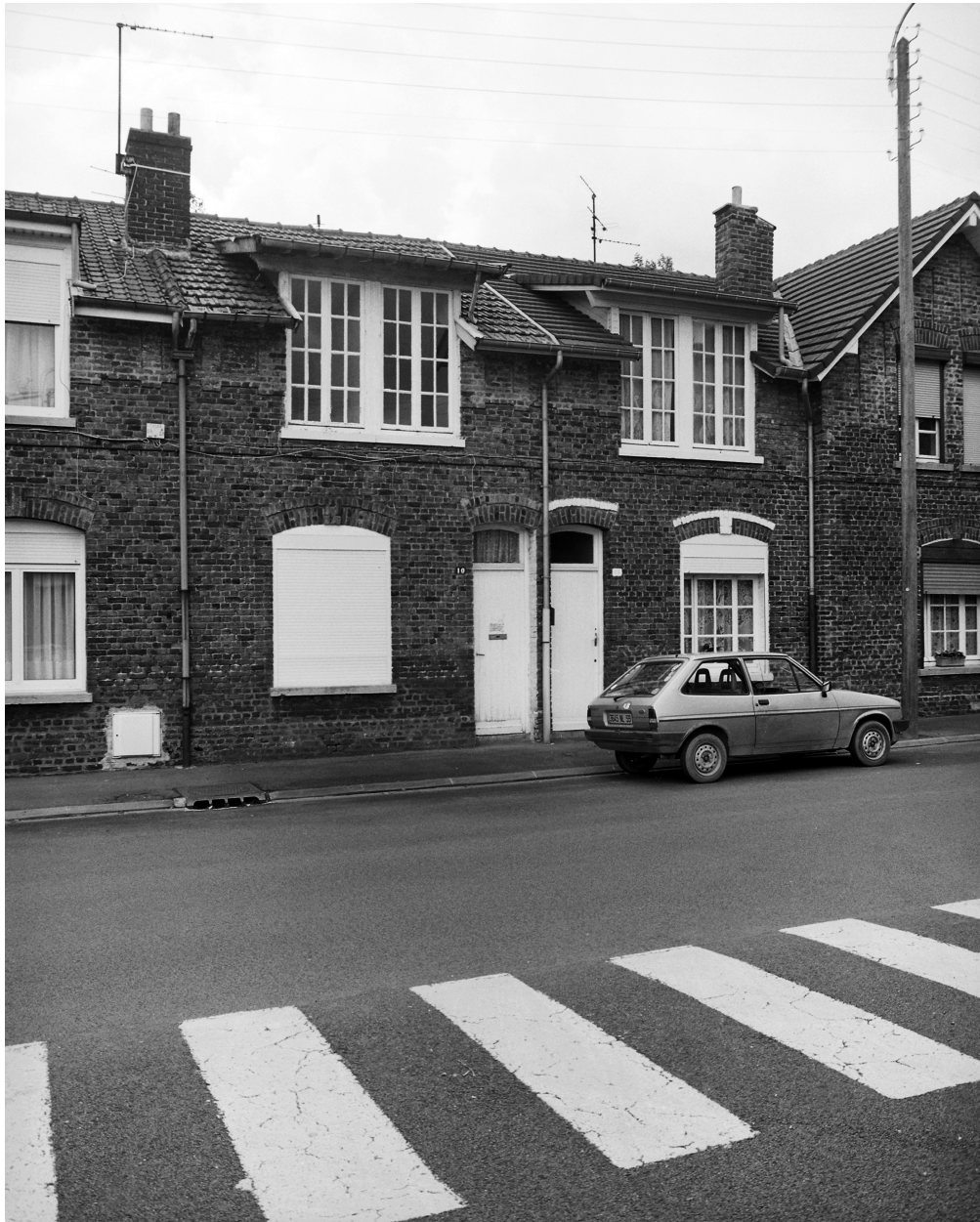
Vue générale d'un module de deux maisons faisant partie du module de six maisons, numéros 10-11 de la rue Gambetta.
