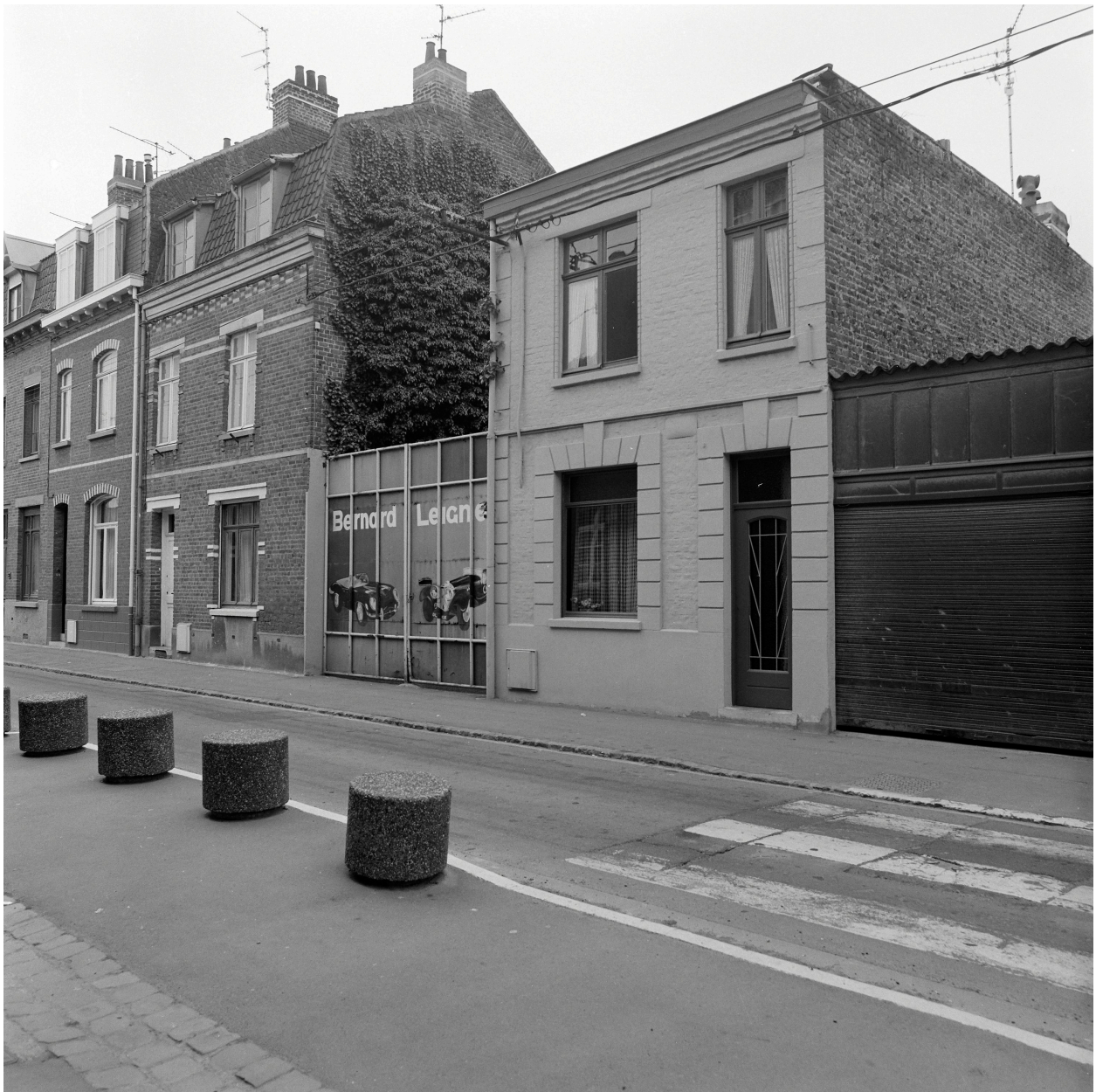
Élévation antérieure, rue Jean-Macé.
