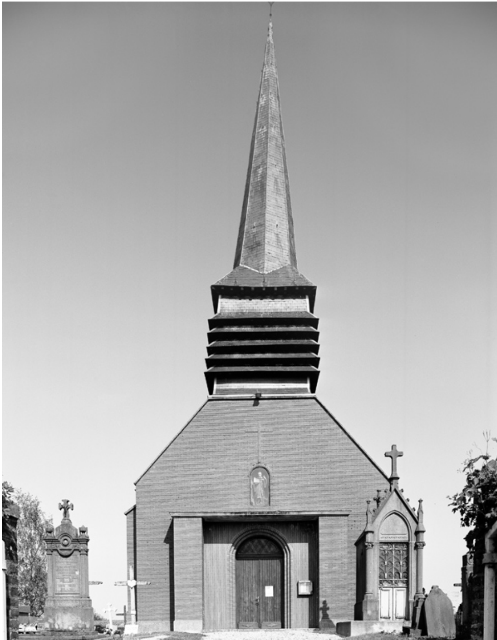
Vue générale de la façade occidentale.
