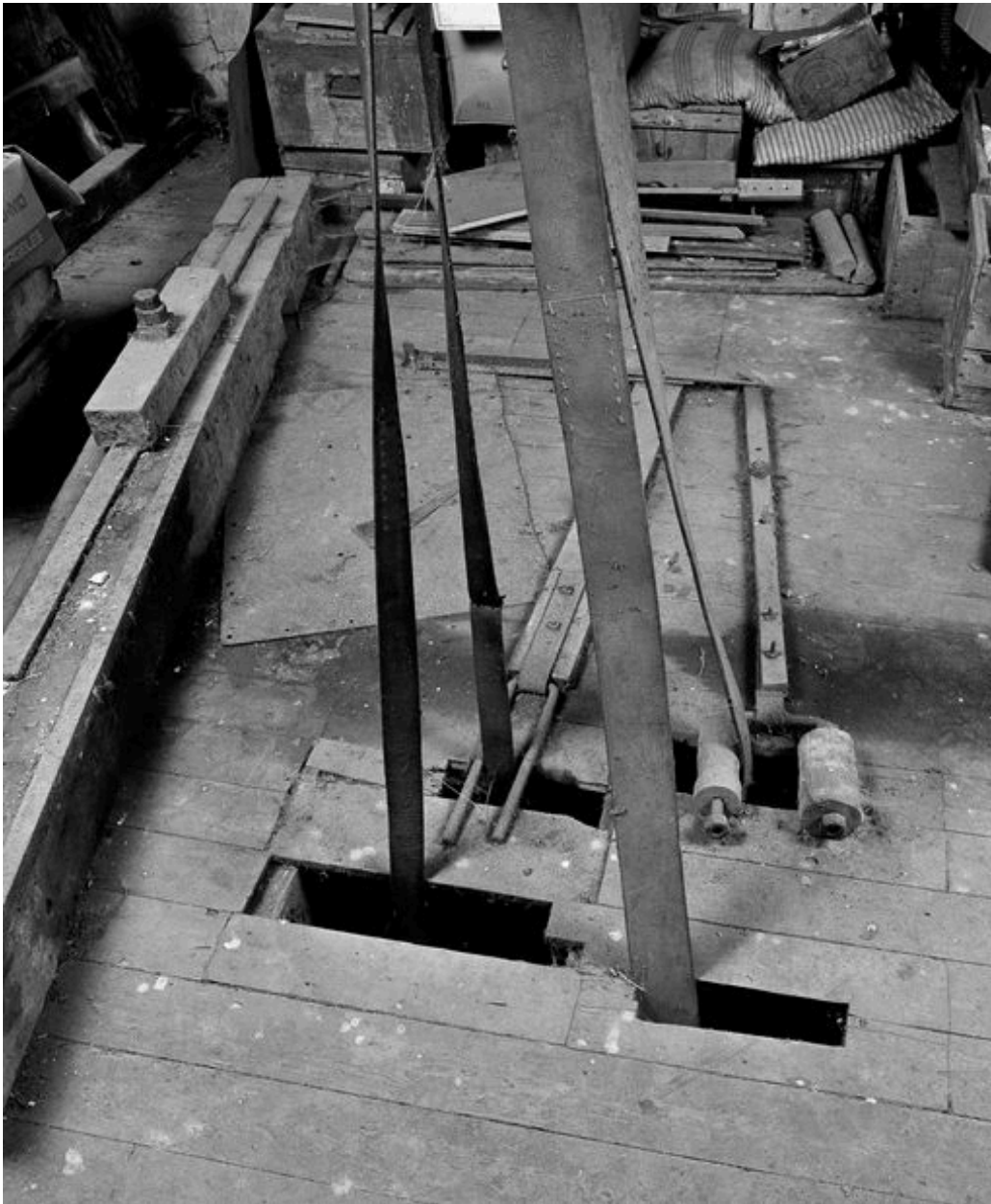
Courroies de transmission, en comble.
