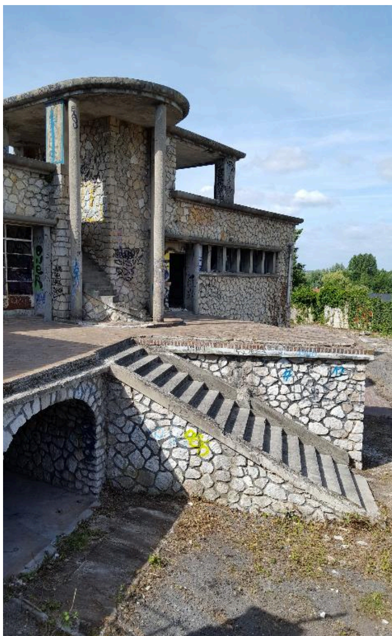
Vue du bâtiment des vestiaires, avec l'escalier descendant vers les bassins.
