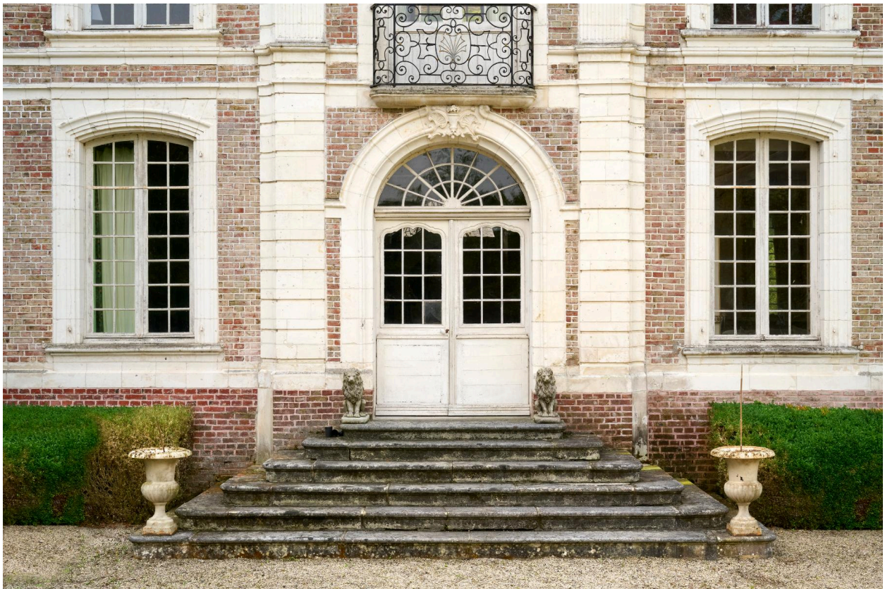
Détail de l'escalier d'entrée nord.
