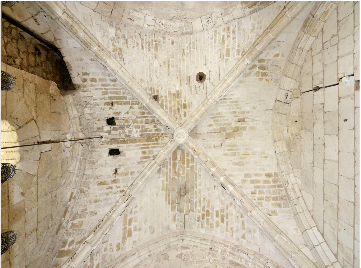
Voûte d'ogives de la salle des gardes.
