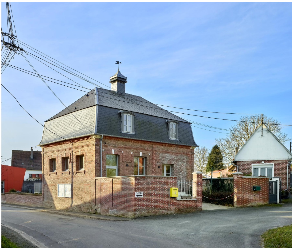
Vue d'ensemble de la mairie prise depuis le nord-est.
