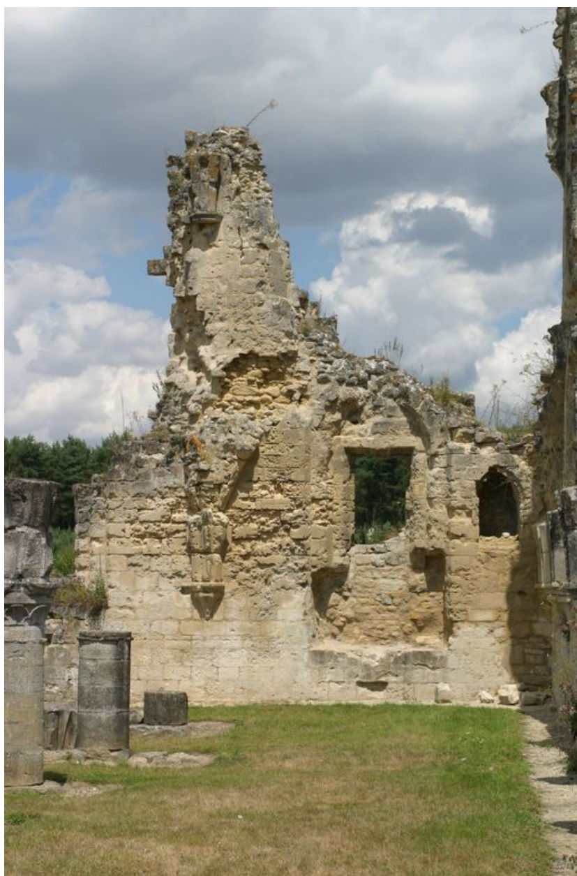
Vue partielle de la salle du chapitre.
