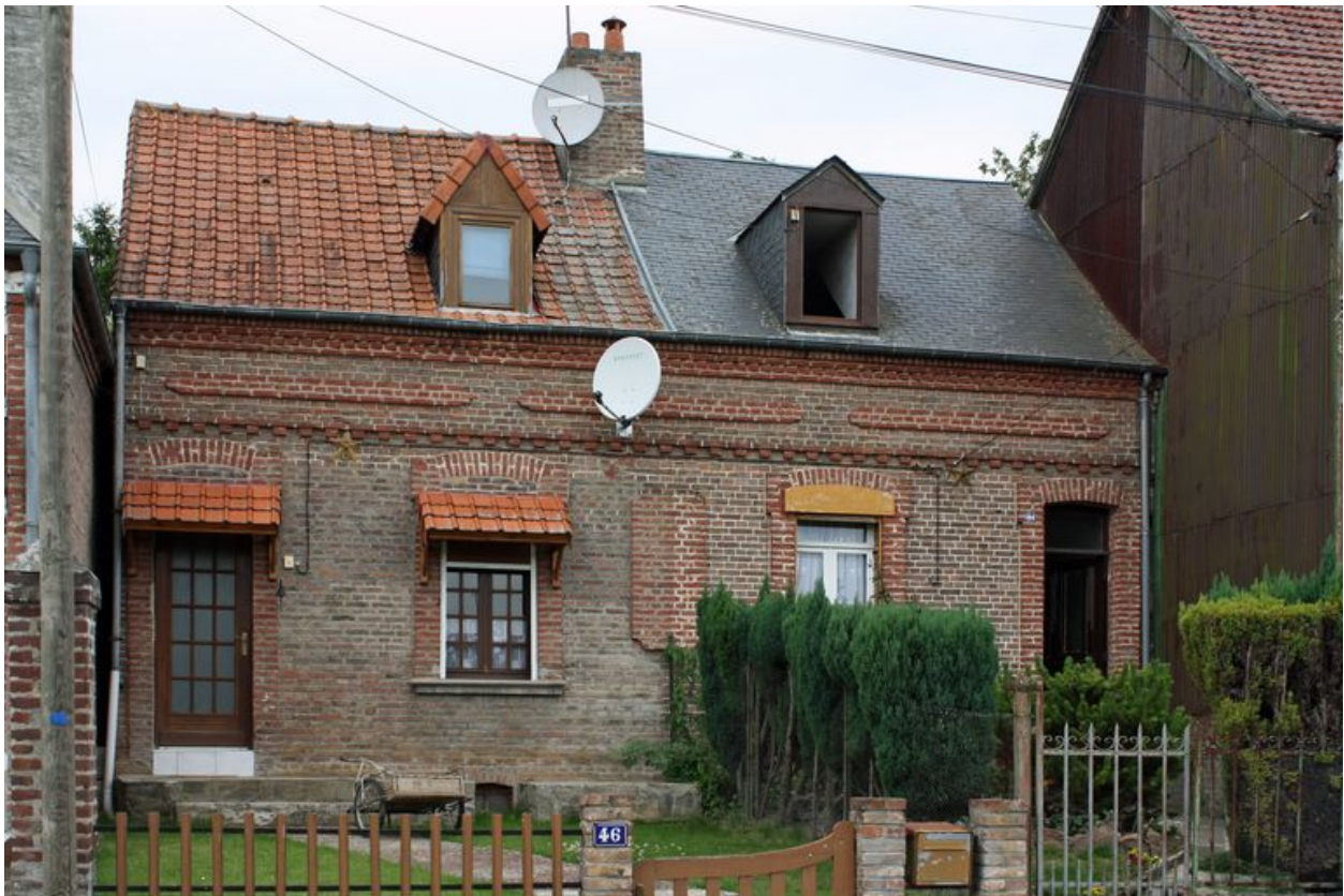
Vue d'ensemble sur rue.
