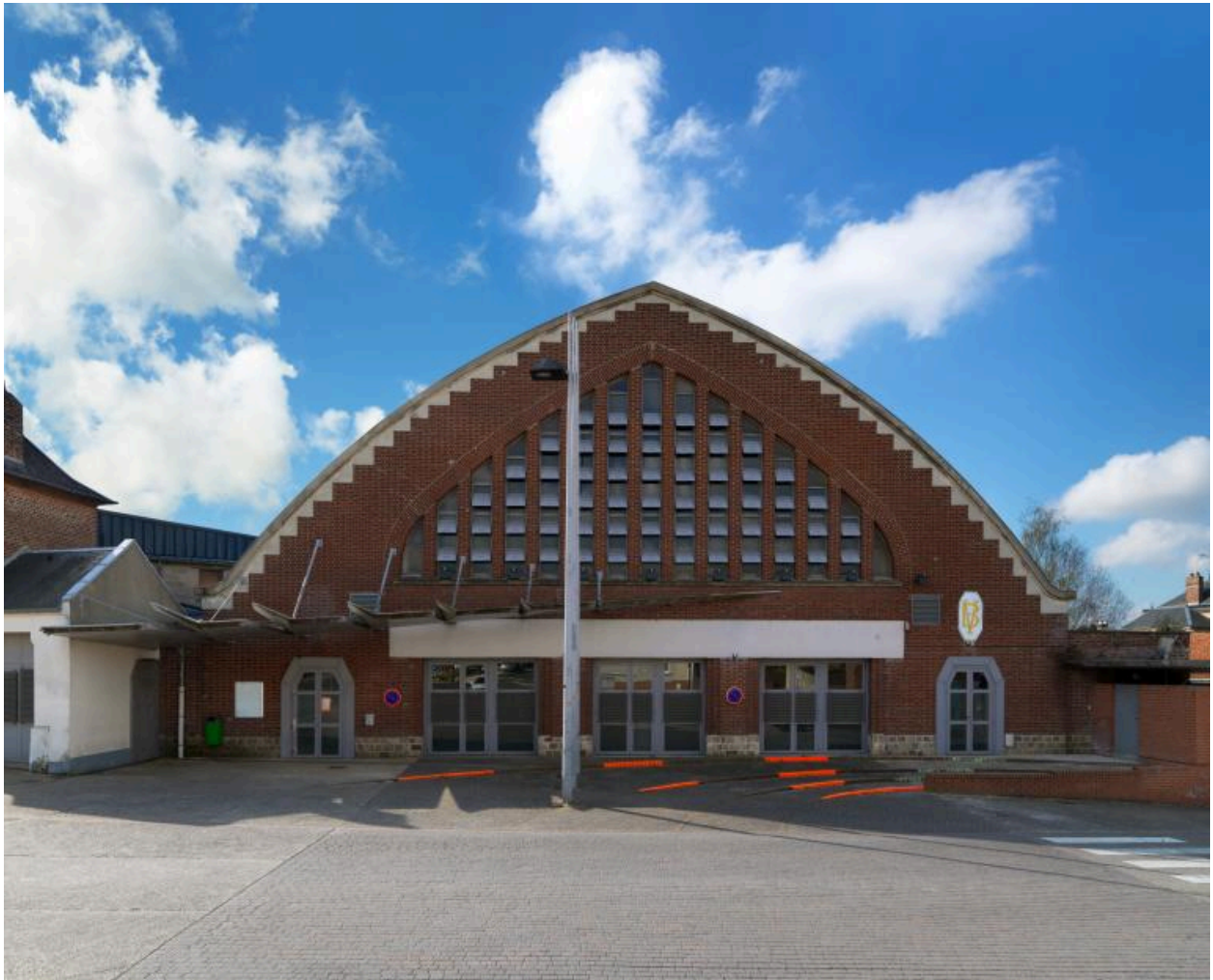
Vue de la façade nord.
