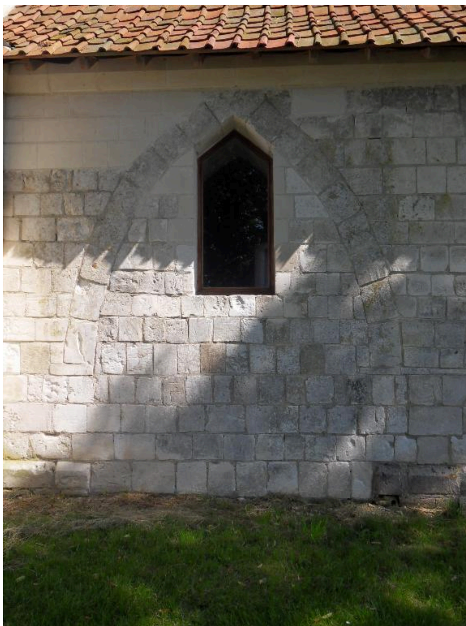
Première arcature mur sud.
