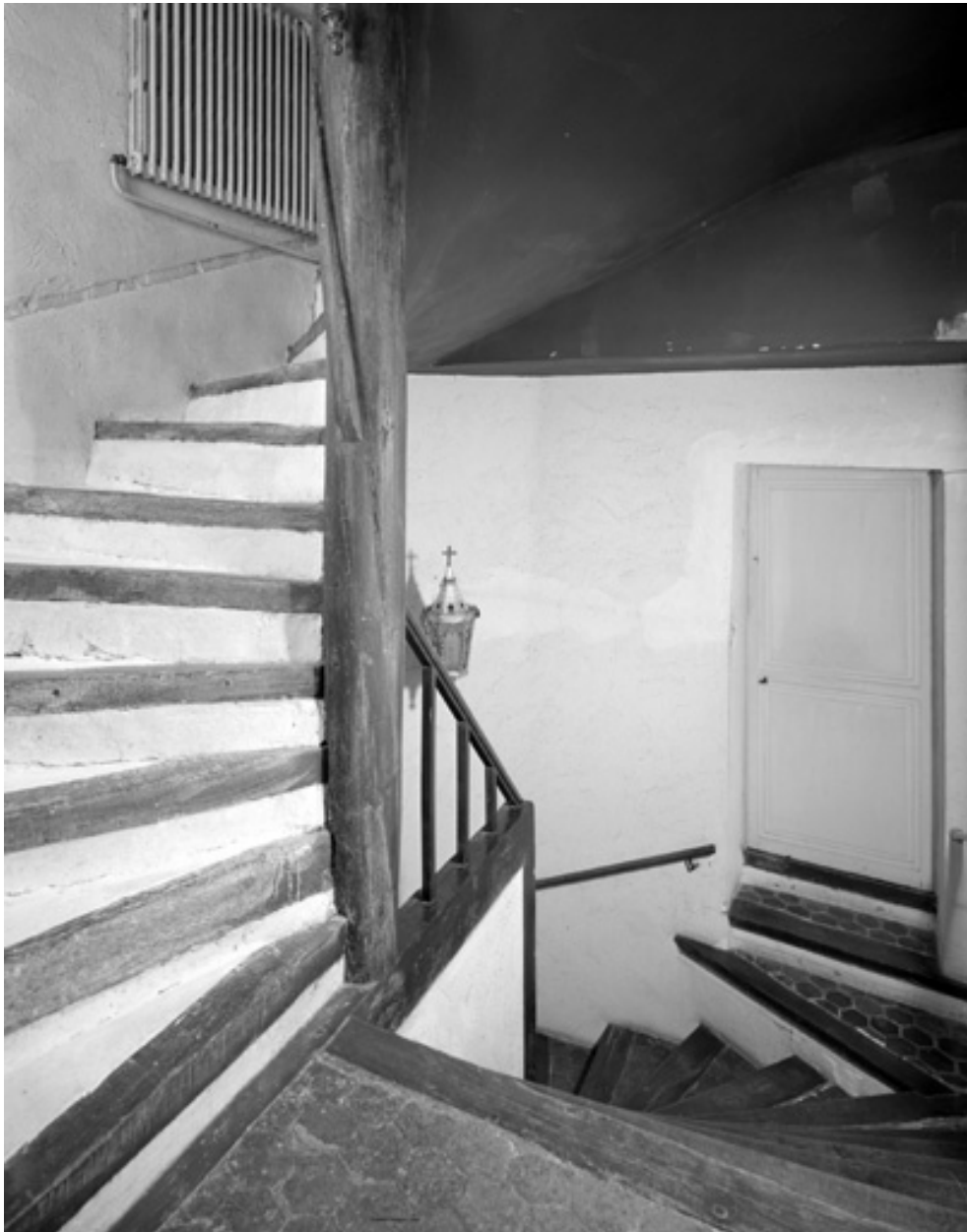
L'escalier, vue prise depuis le premier étage.
