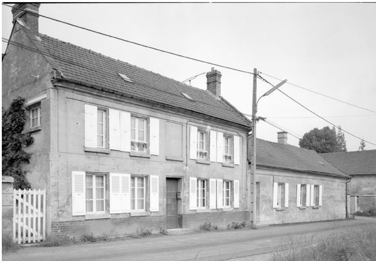
Logis. Élévation antérieure.
