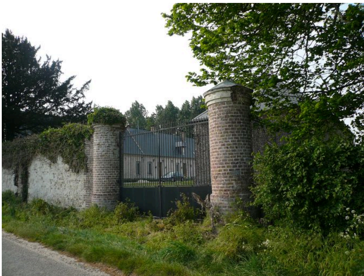
Vue de l'entrée au sud de la cour.
