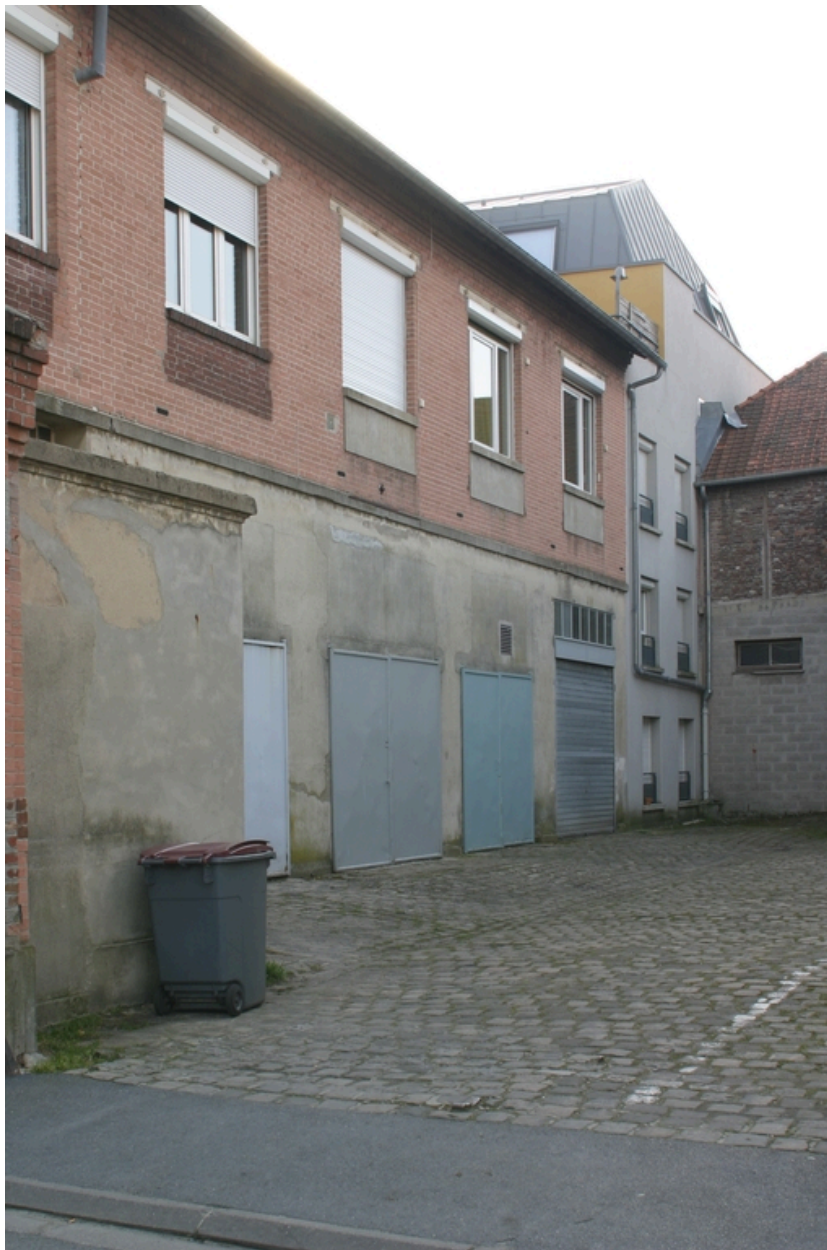
Façade antérieure d'un atelier de la rue de Vicq.
