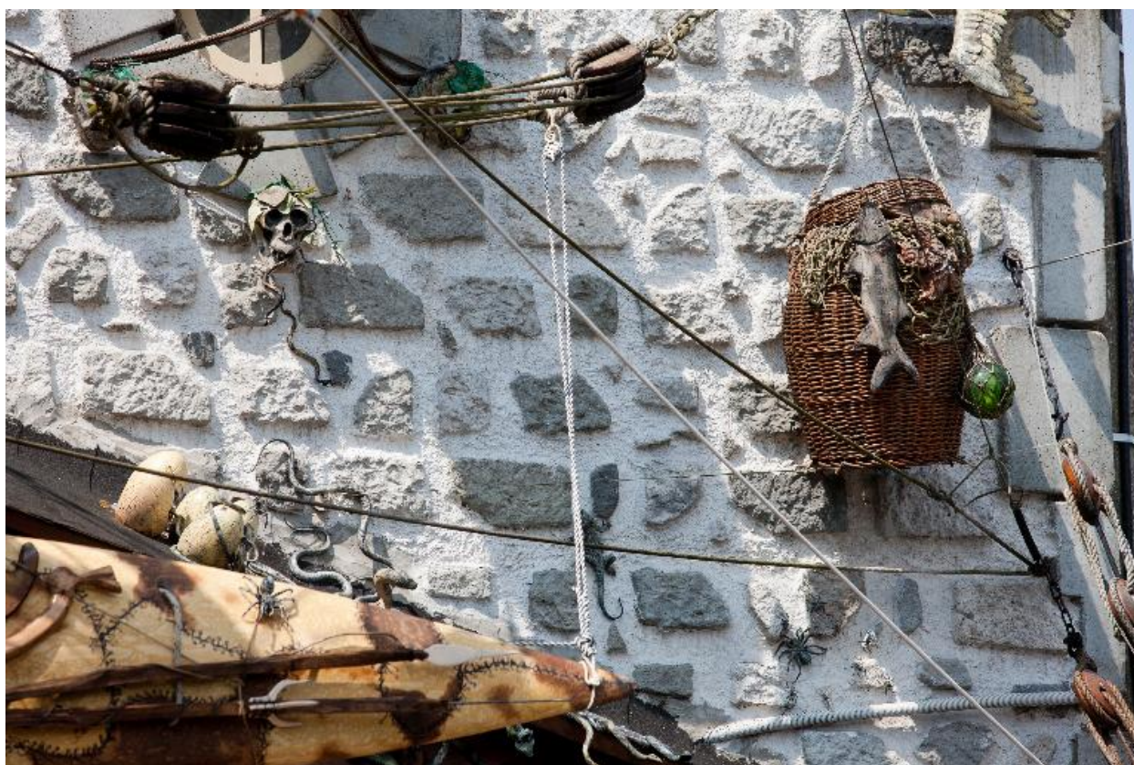
Vue partielle du pignon.
