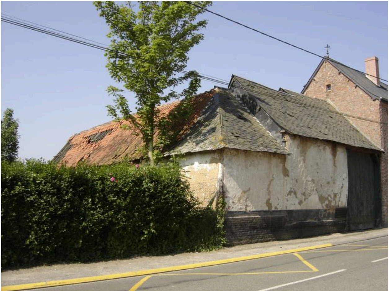
Vue latérale de la grange et du passage couvert.
