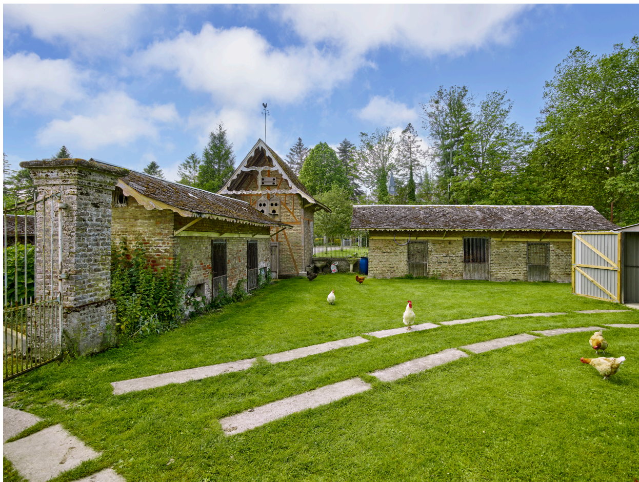
Vue de la cour nord de la ferme, depuis l'est.
