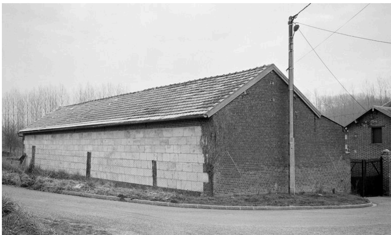
Remise agricole : façade sur rue.
