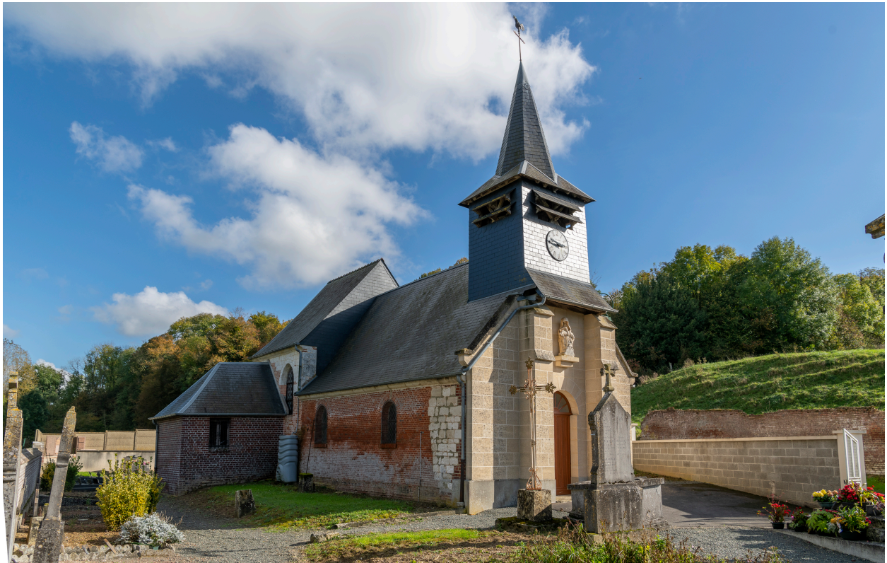
L'église entourée du cimetière, vue depuis l'ouest.
