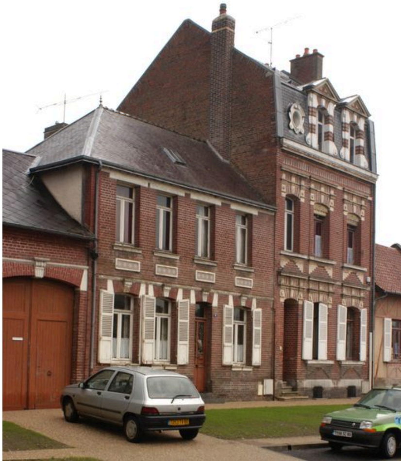
Vue partielle, depuis le nord-est.
