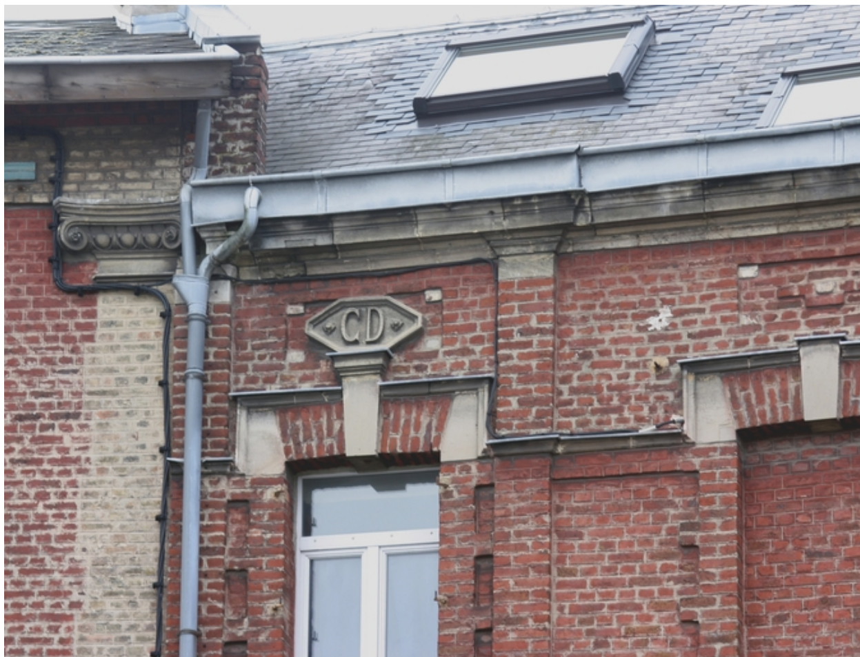
Façade antérieure des logements d'employés : détail.
