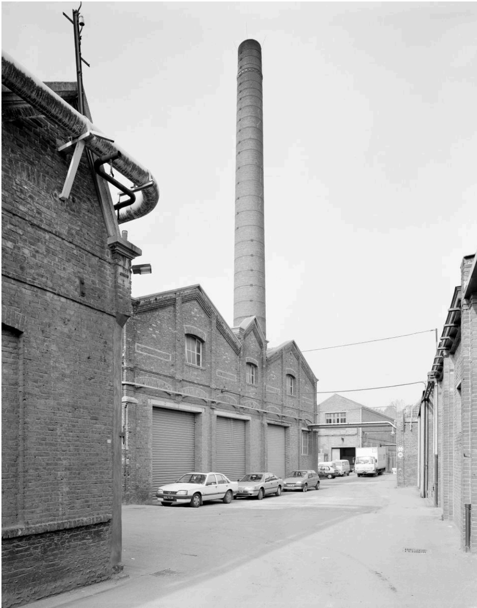
Chaudière (ancien crémage). Vue prise vers le nord-ouest.
