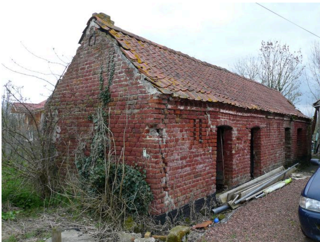
Vue des porcheries au nord-ouest.
