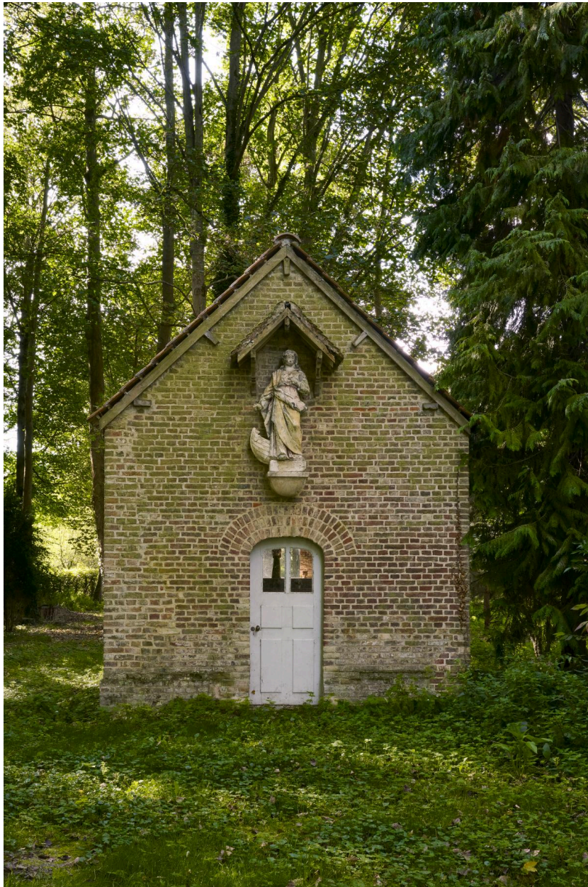
Façade nord-est de la chapelle.
