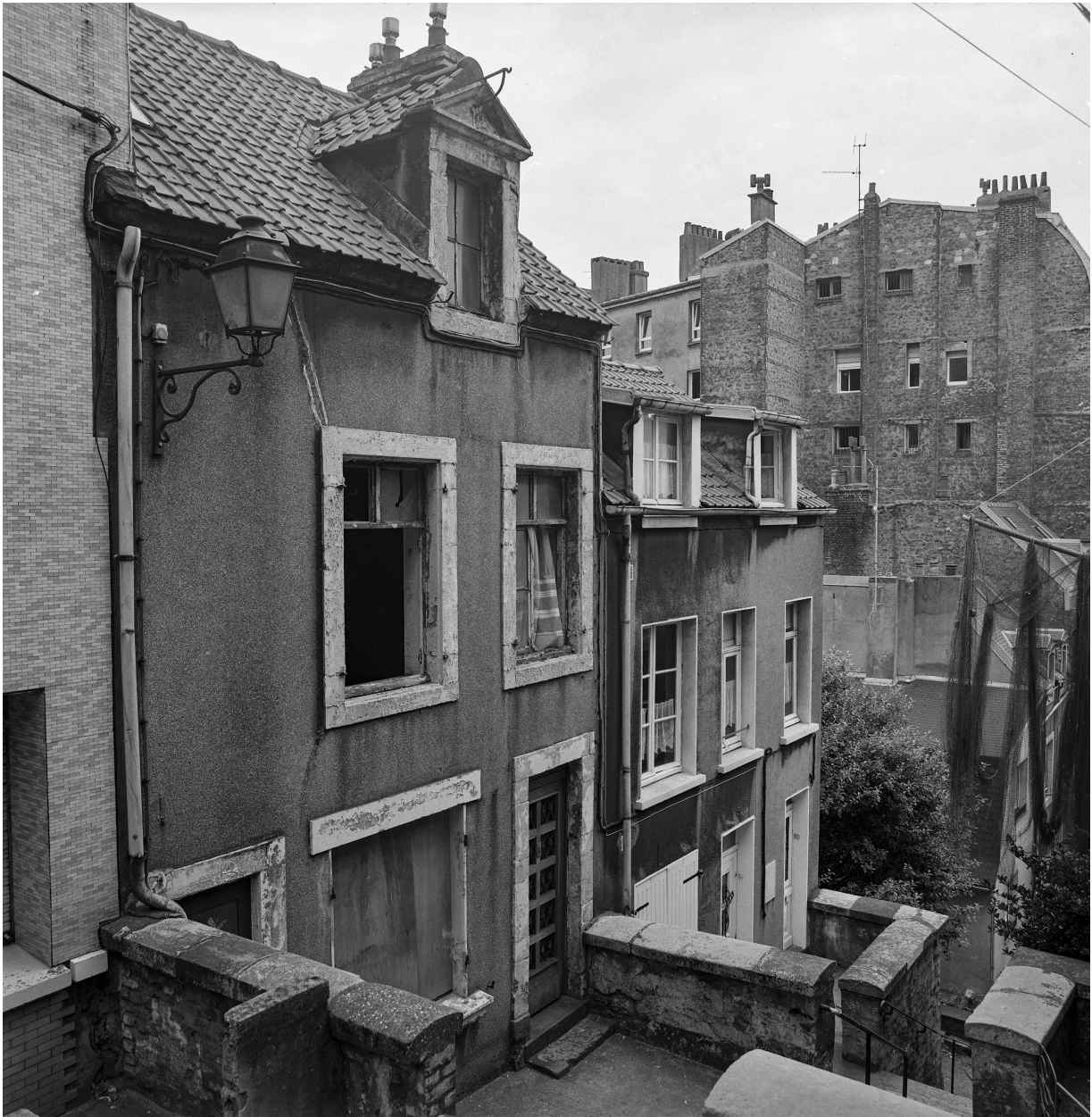
Vue générale de la voie.
