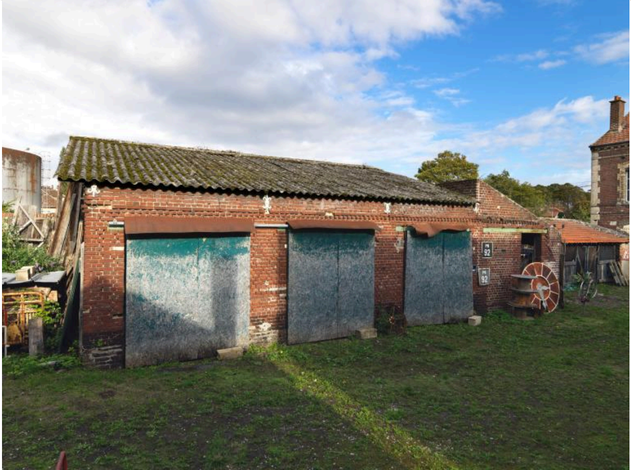
Ancienne scierie Delaplace, fabrique Moores and Cie et logements de cheminot : trois garages ou remises au nord-ouest de la cour et appentis de buanderie
