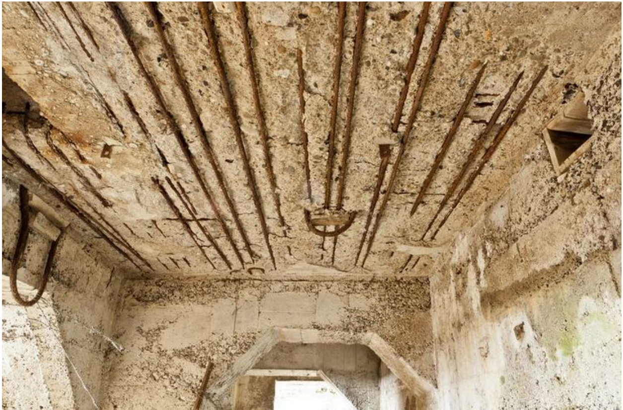
Couloir, détail du couvrement
