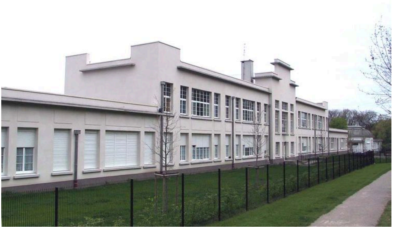
Façade arrière, vue générale, état en 2005 après réhabilitation en logements.
