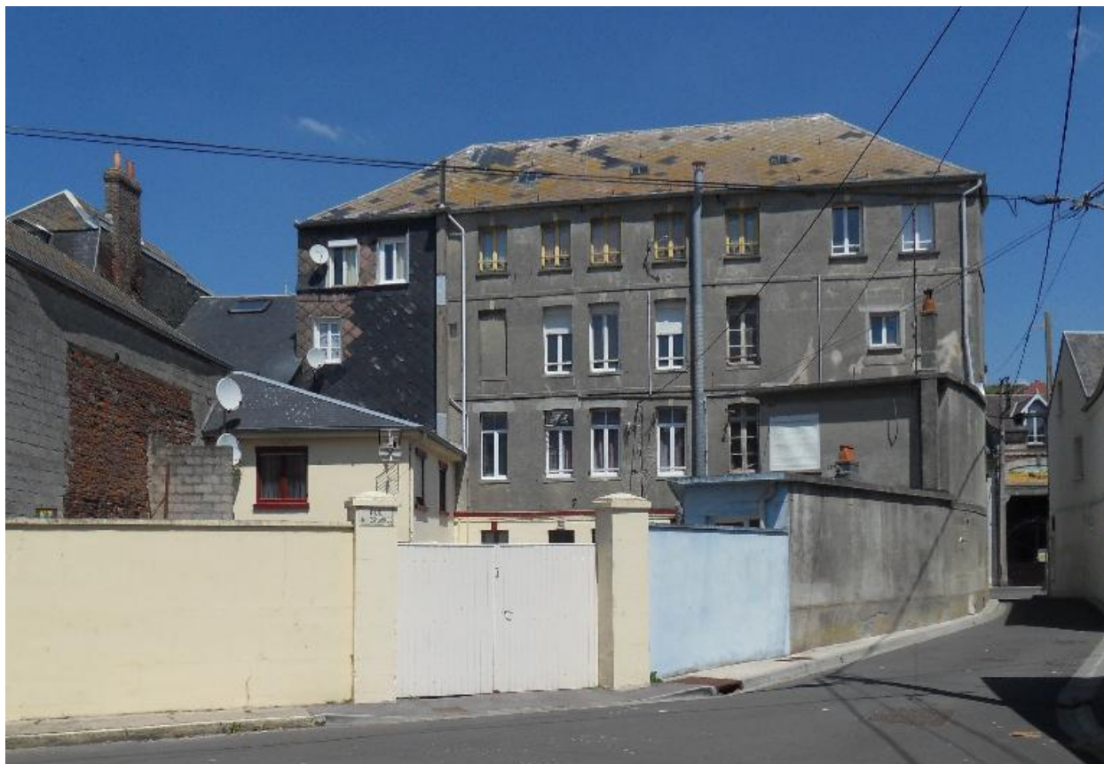
Vue de la façade postérieure.
