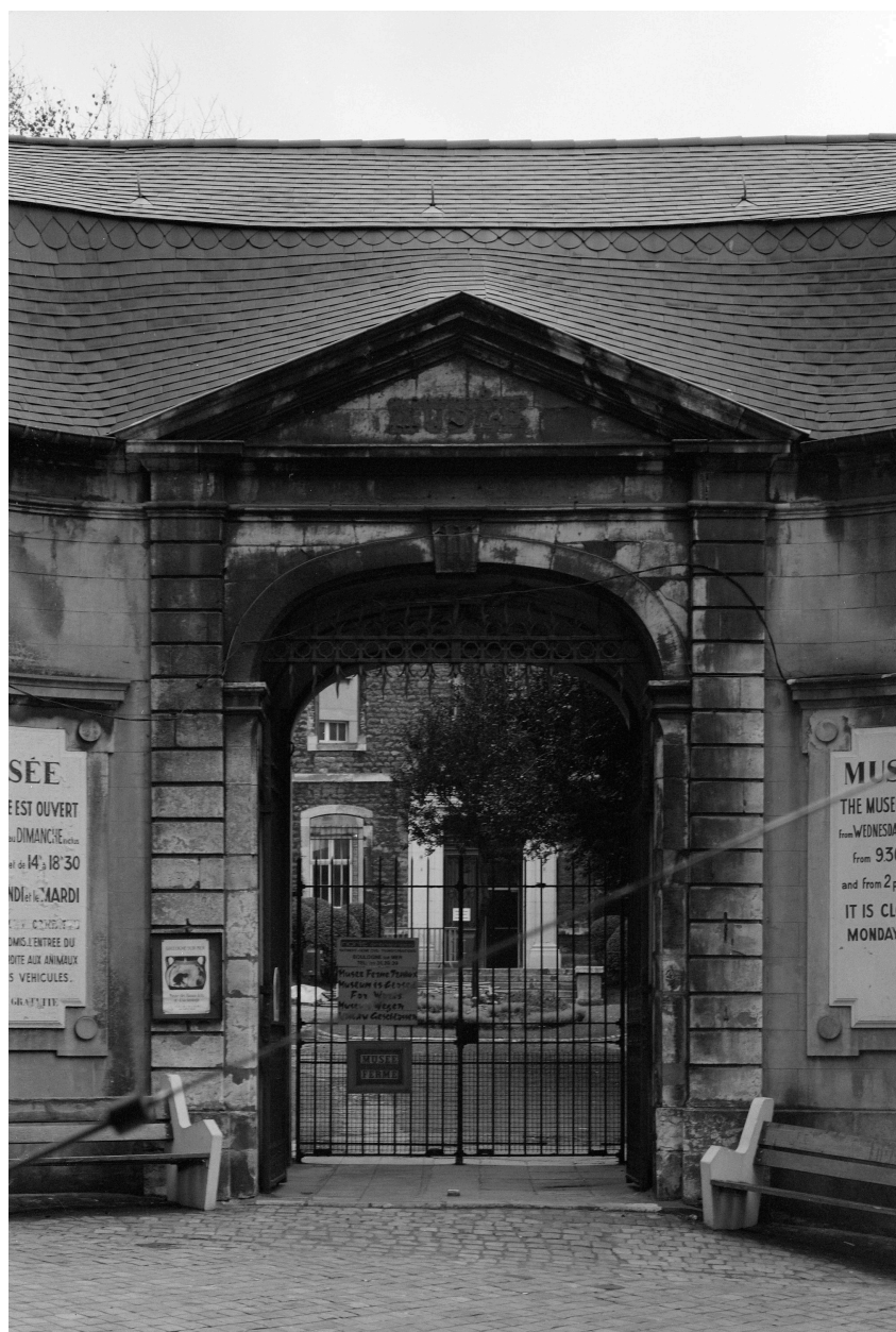
Porte cochère, façade sur voie.
