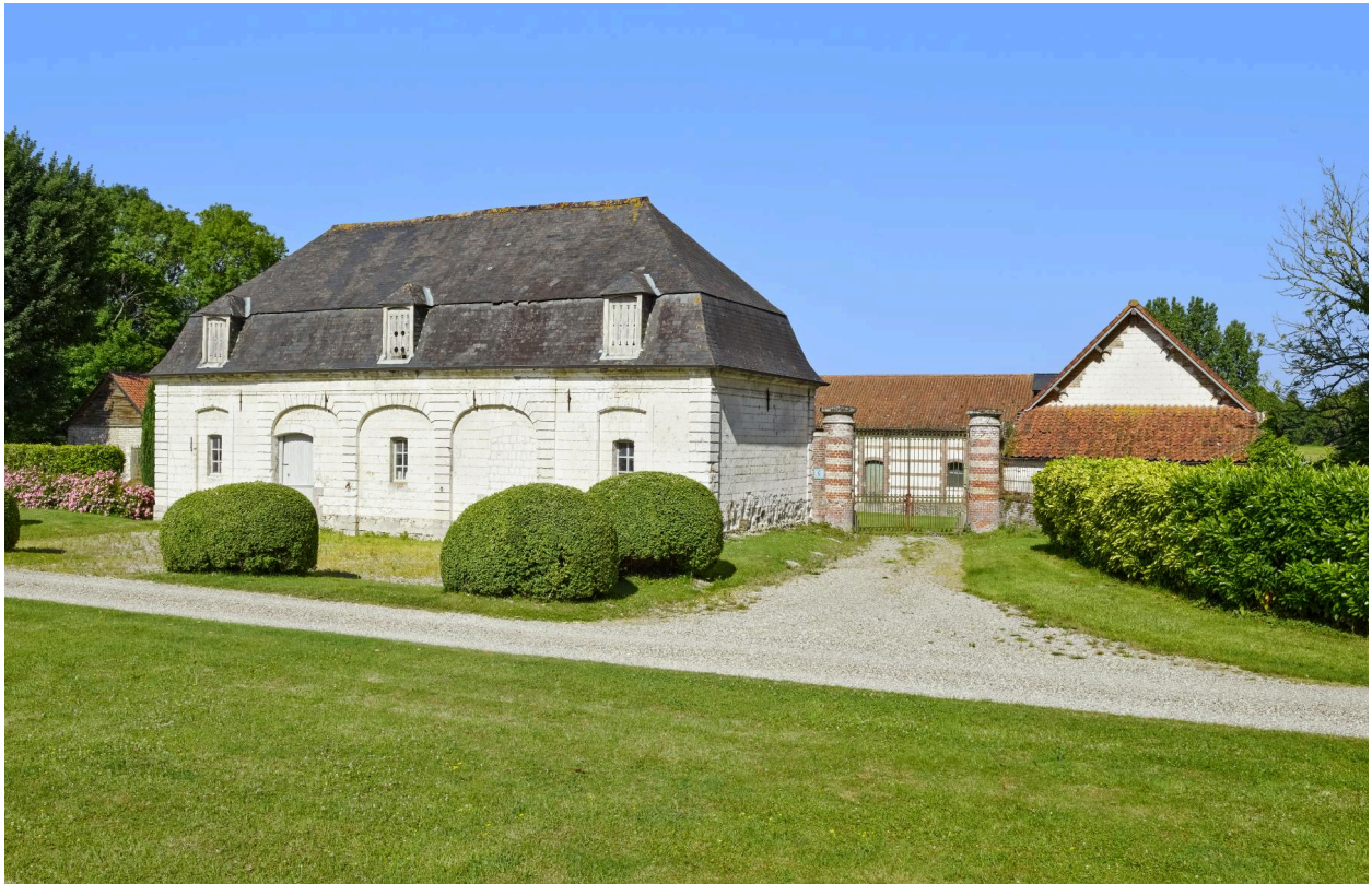
Façade sur parc de l'écurie et de l'entrée de la ferme.
