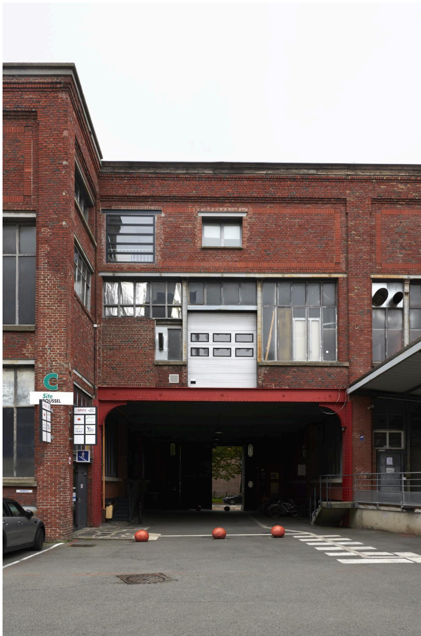
Bâtiment donnant rue des Arts, vue de l'arrière sur cour.
