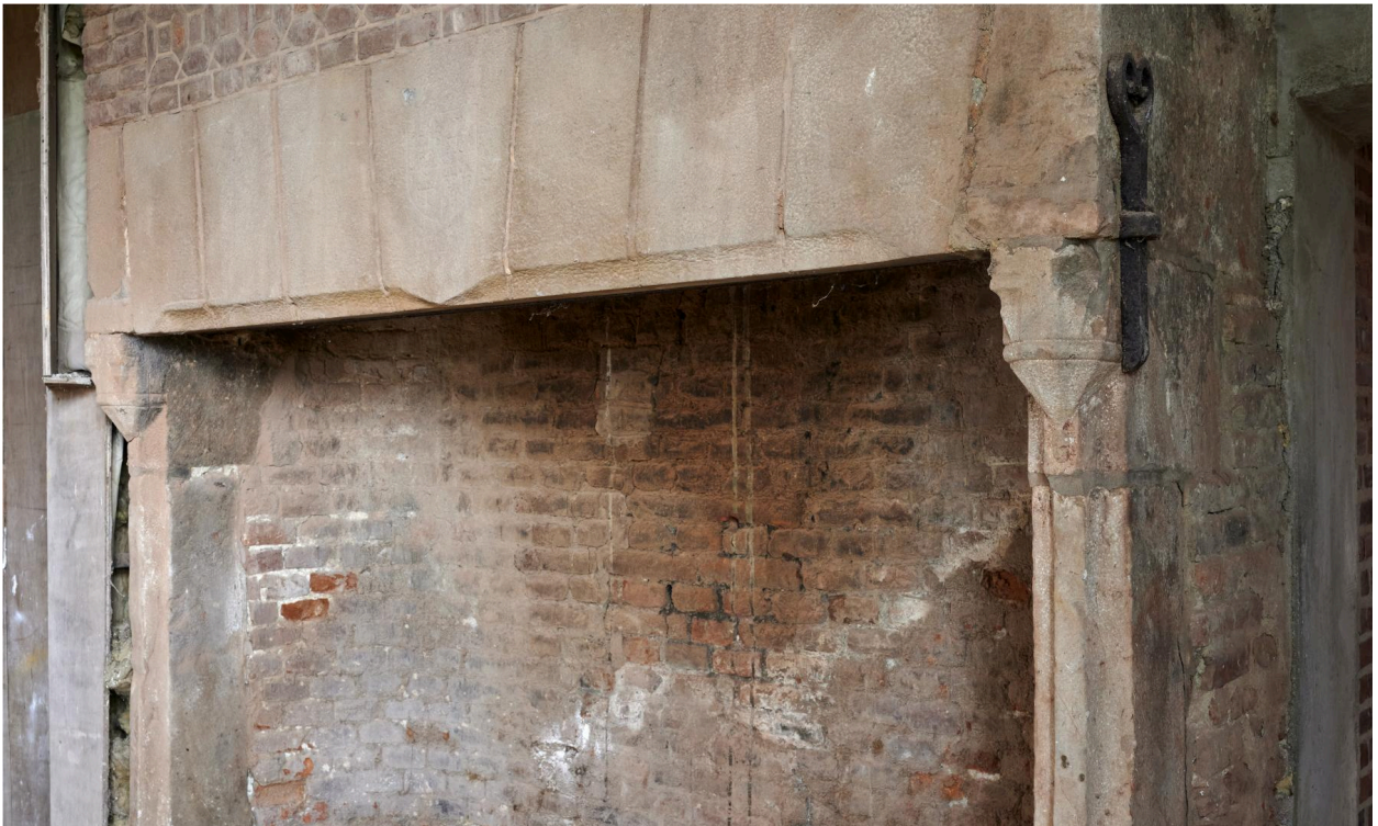
Rez-de-chaussée. Logis du XVIIe siècle. Détail de la cheminée de la salle principale.
