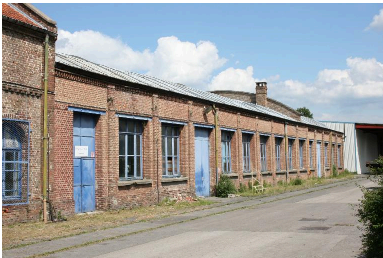
Façade sud des magasins.
