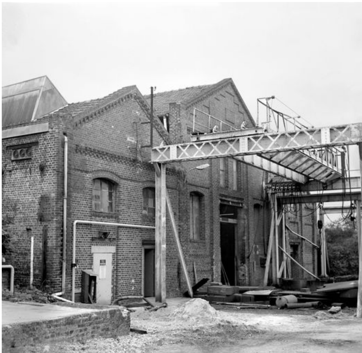
Atelier de fabrication 1, flanc ouest.
