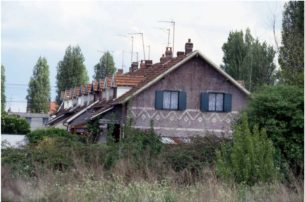
Immeuble à logements des ouvriers, vue prise en 1992. Alignement des lucarnes de l'étage de comble et détail des motifs en brique silico-calcaire.
