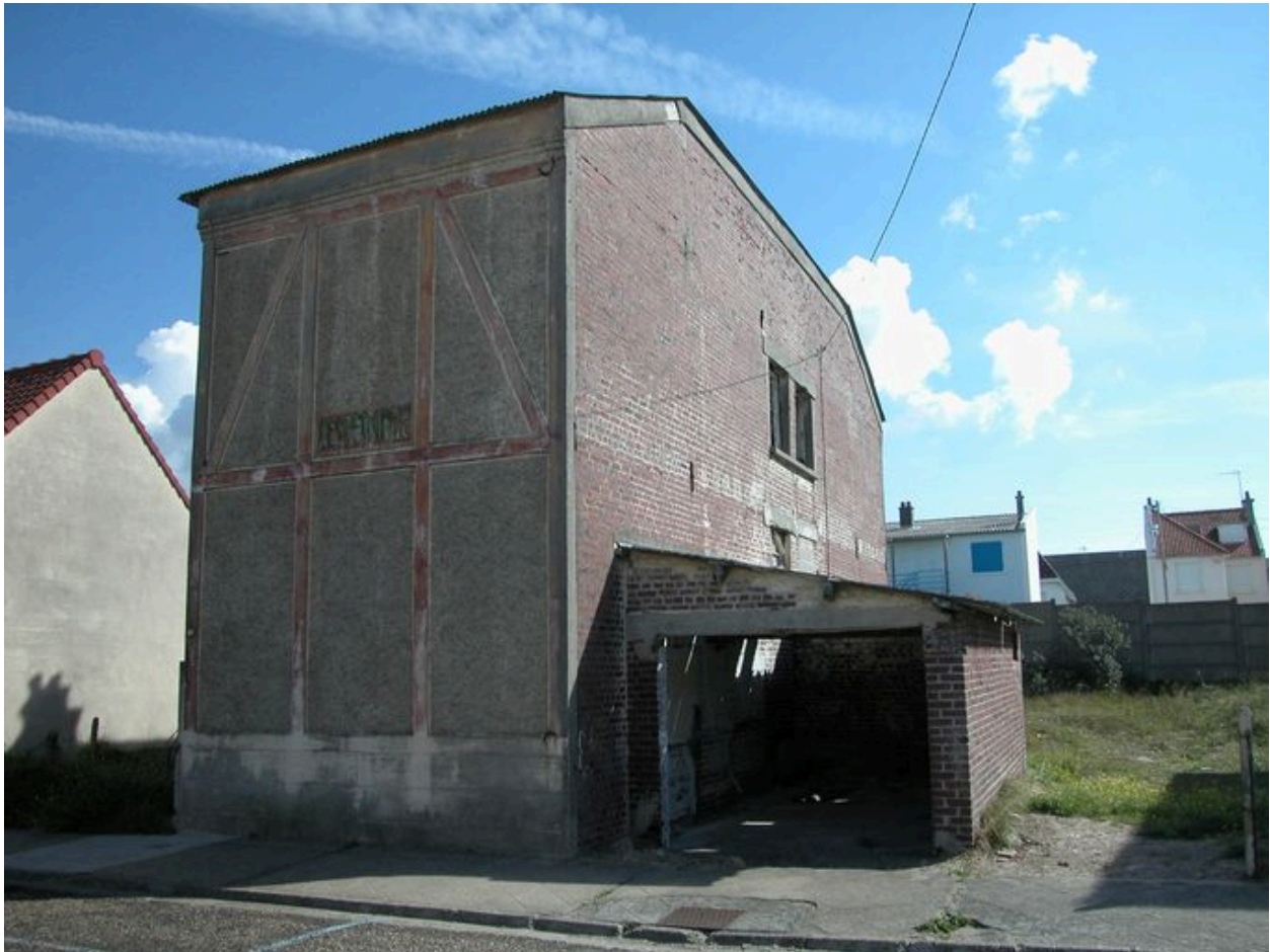
Élévation postérieure et garage accolé.
