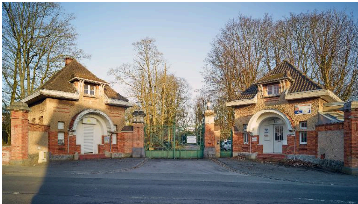
Entrée secondaire de l'hôpital, élévation antérieure donnant sur la route, vue générale.
