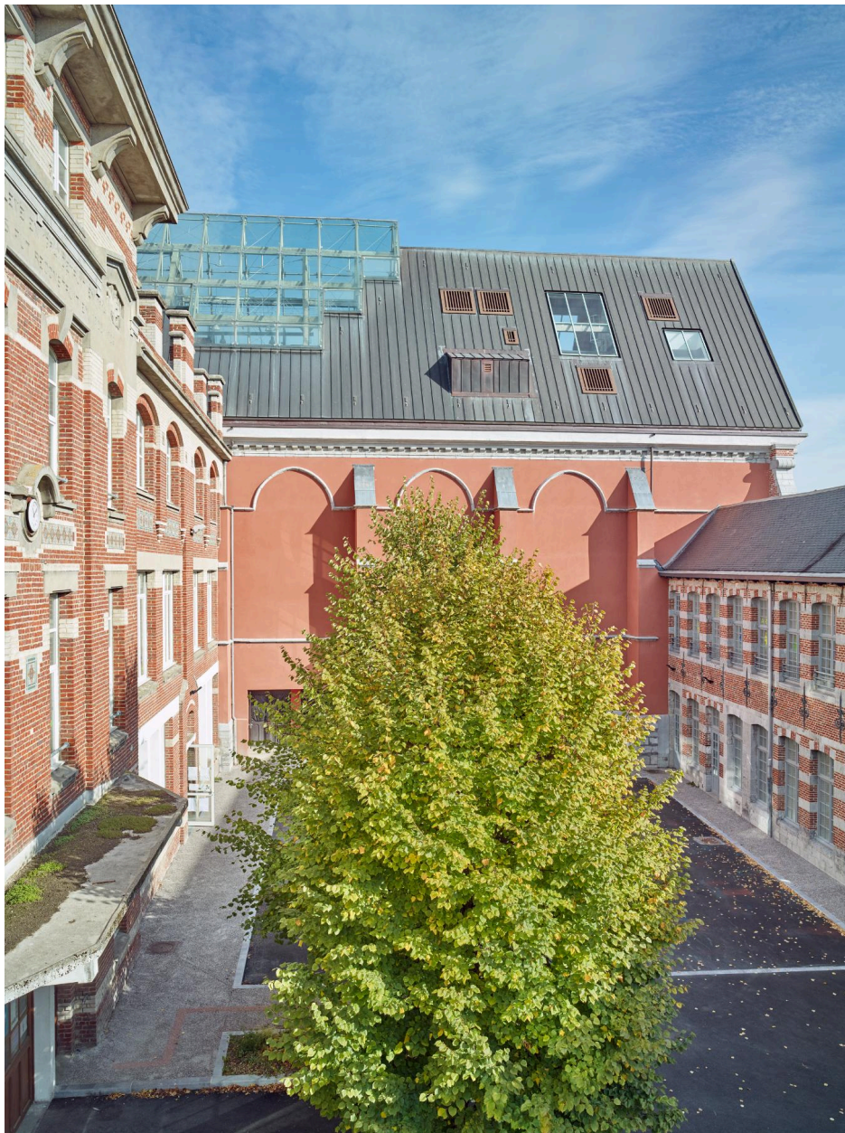
Vue depuis la cour au sud.
